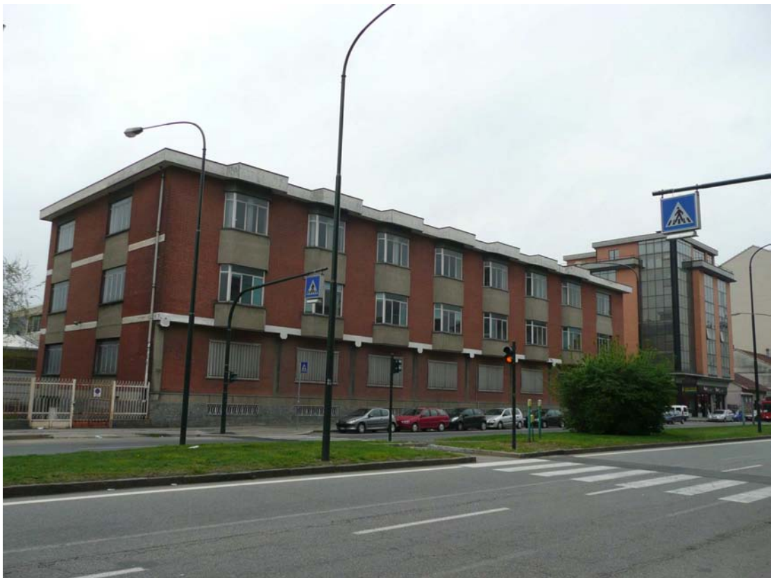
Il fabbricato lato via Sansovino (vista da nord)
