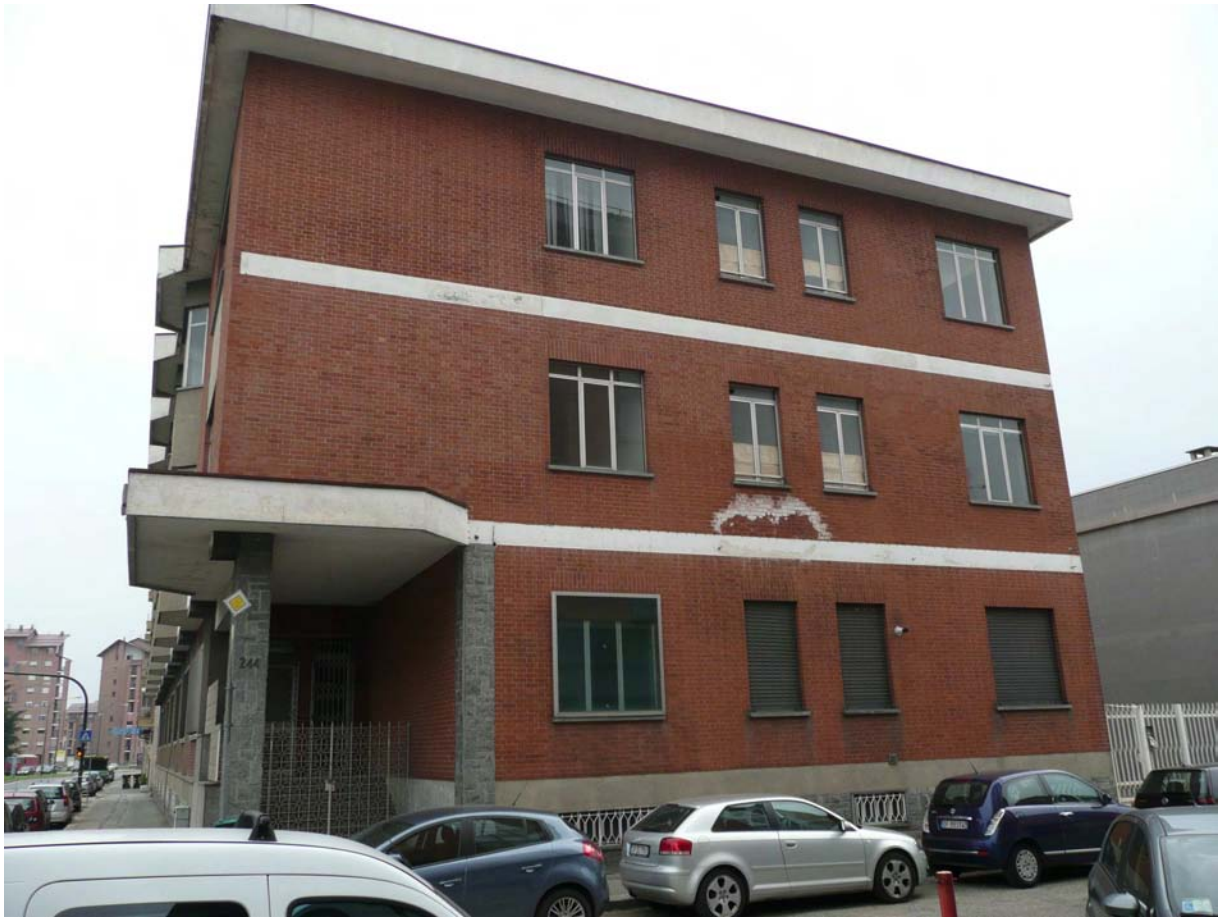
Facciata sud dell'edificio oggetto dell'intervento (Interno di via Sansovino)
