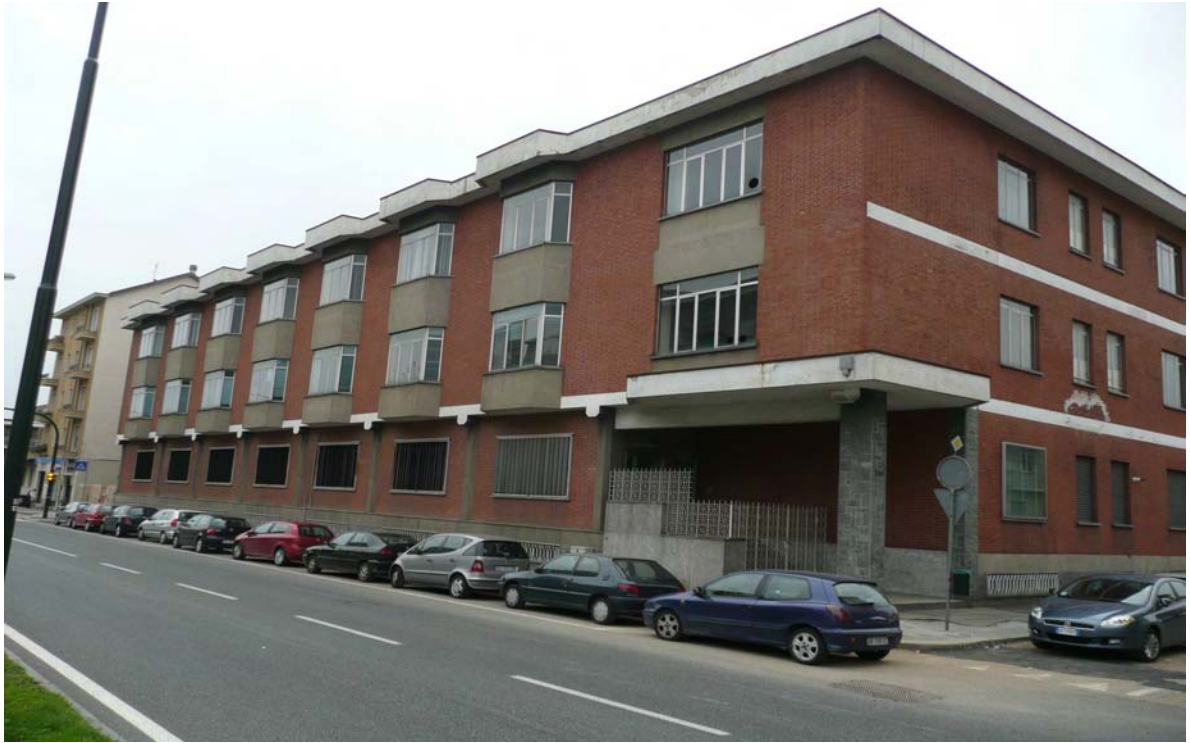
Il fabbricato lato via Sansovino ( vista da sud )
