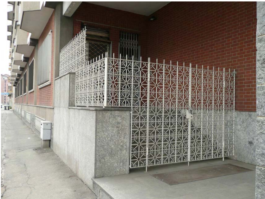
Dettaglio dell'ingresso principale dell'edificio oggetto dell'intervento
