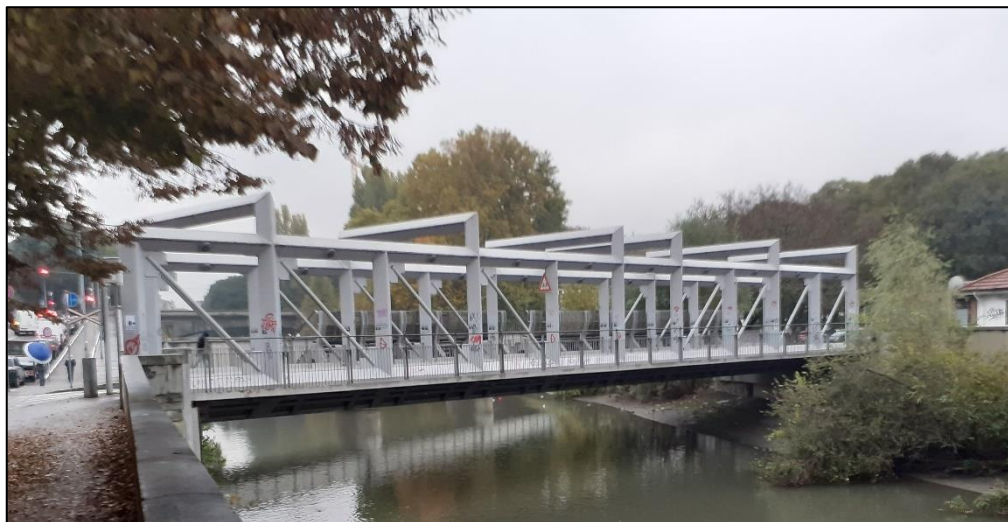
Figura 13 – Vista da monte del ponte Carpanini in condizioni di normale esercizio, pertanto non sollevato.
