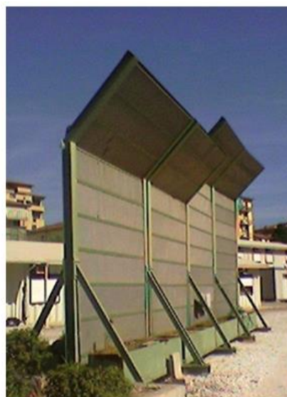
Figura 274. Schema tipologico barriera acustica (a sinistra) ed esempio di schermature fonoisolanti e fonoassorbenti di tipo mobile/rilocabile.
