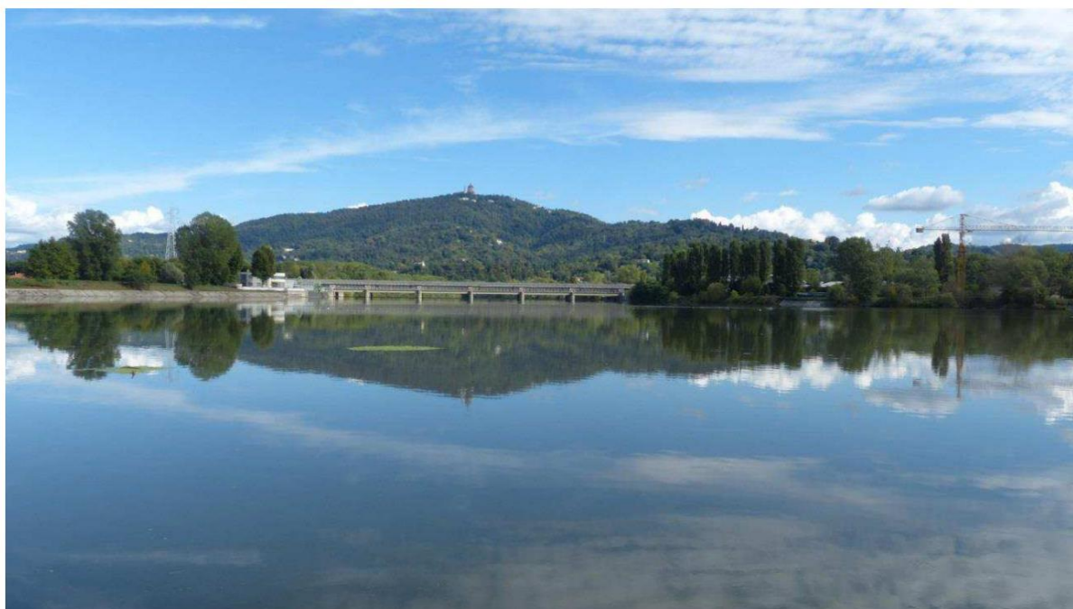
Figura 84. La diga del Pascolo e l'invaso, veduta dalla confluenza tra Po e Stura di Lanzo
