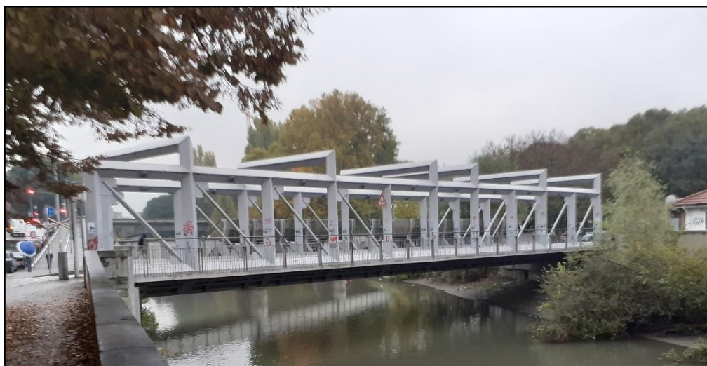
Figura 118. Vista da monte del ponte Carpanini in condizioni di normale esercizio, pertanto non sollevato.
