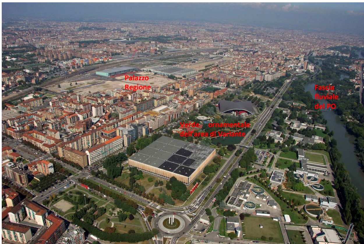
Figura 88: Vista aerea panoramica dell'ambito di trasformazione. Rispetto alla visuale in figura lo stato attuale delle aree presenta il nuovo grattacielo del Palazzo della Regione, in fase di ultimazione
