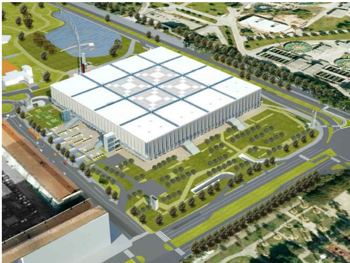
Figura 92: Vista Via Ventimiglia - Corso Maroncelli
