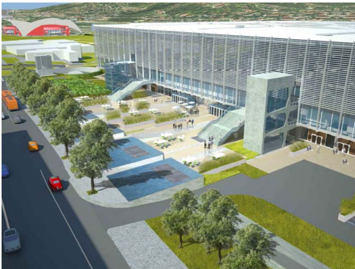
Figura 97: Vista della piazza su via Ventimiglia
