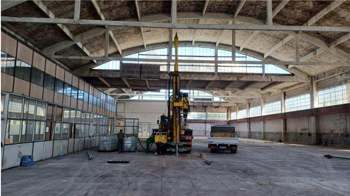
Figura 19: Esecuzione prova SPT
