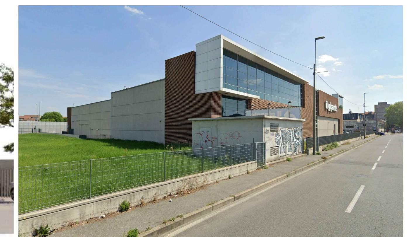
EDIFICIO C - Vista da Via Corso Marche
