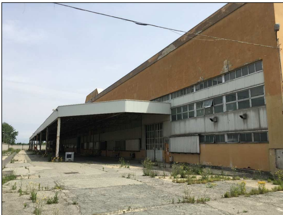
Figura 2 - Stato attuale del Fabbricato 37 – Prospetto Principale con tettoia metallica.
