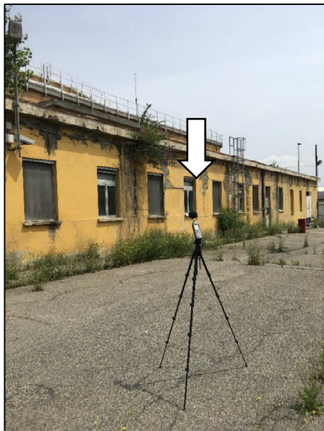
Figura 9 - Foto della Postazione di Misura P1 - Viale di accesso principale da Corso Marche.
