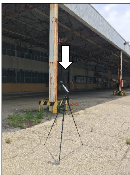
Figura 12 - Foto della Postazione di Misura P4 - Resede interno del fabbricato lato Nord
