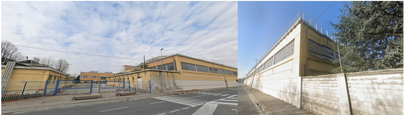
Figura 6 - Vista ingresso- fonte Google Maps
