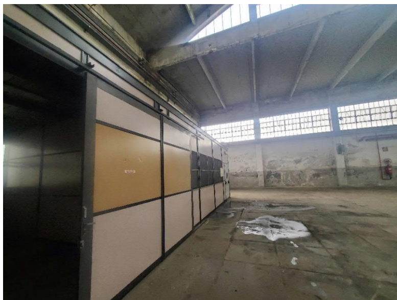
Figura 11: Interno Fabbricato principale n.37
