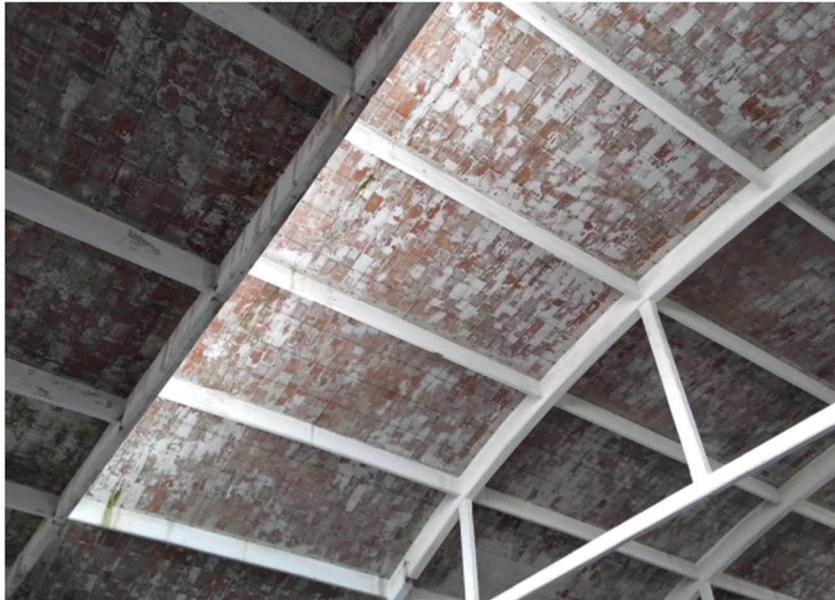
Figura 9: Interno Fabbricato principale n.37
