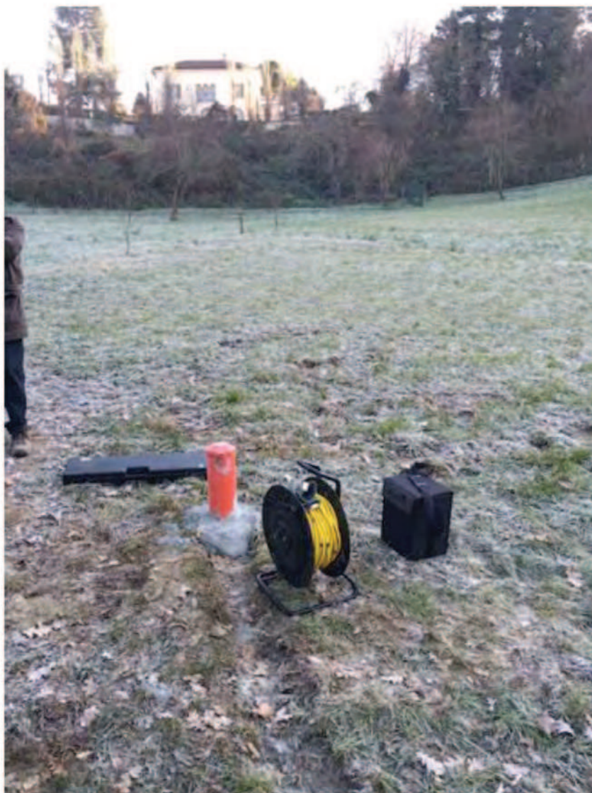
tubazione inclinometrica realizzata nel novembre 2015 ed oggetto di monitoraggio
