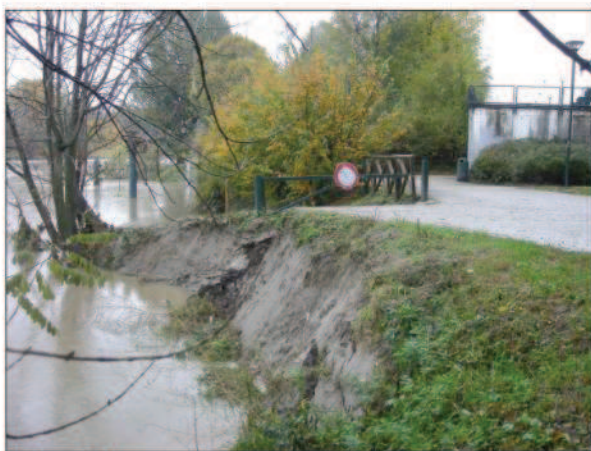
A sinistra: erosione lungo la sponda destra Po presso il centro sportivo di C.so Sicilia. A destra il sentiero pedonale allagato lungo la sponda sinistra a monte del P.te Balbis
